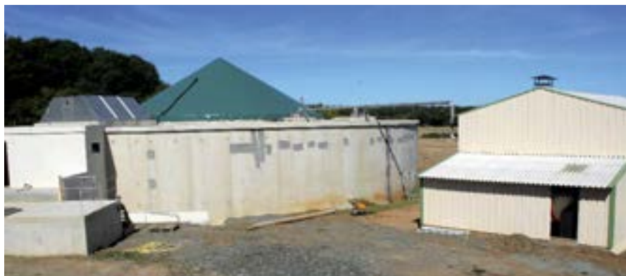
La structure abritant le digesteur produisant du biogaz et le bâtiment pour la cogénération d'électricité et de chaleur (deux moteurs alimentés par 2 400 m 3 de biogaz/jour).
