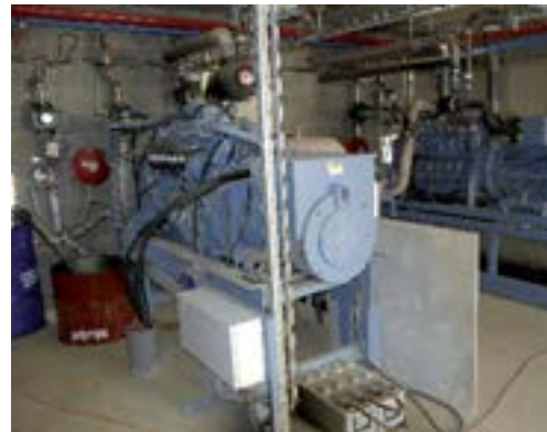
La structure abritant le digesteur produisant du biogaz et le bâtiment pour la cogénération d'électricité et de chaleur (deux moteurs alimentés par 2 400 m 3 de biogaz/jour).
