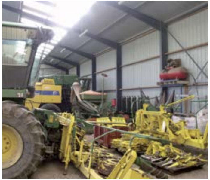
Les locaux de remisage des matériels peuvent être conçus sur le même principe que l'atelier, en particulier en ce qui concerne l'utilisation de la lumière naturelle.
