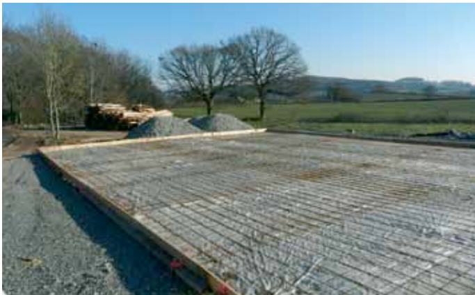
Des travaux ont actuellement lieu pour augmenter l'aire de stockage des plaquettes.
