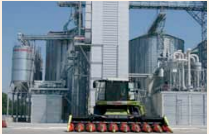
L'installation de séchage de la SNC Sama traite chaque jour 30 000 quintaux récoltés par quelques-unes des dix moissonneuses intervenant à l'automne.
