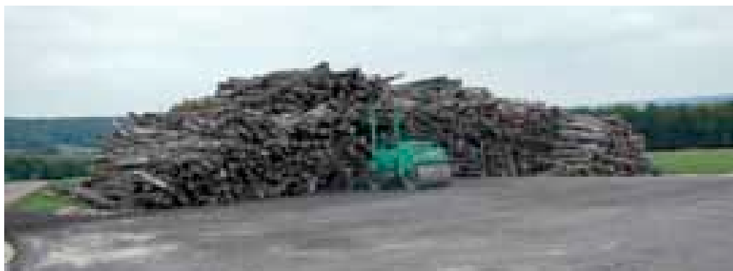
Travaux d'agrandissement de la plateforme avec aire bétonnée pour suivre le développement du bois-énergie.
