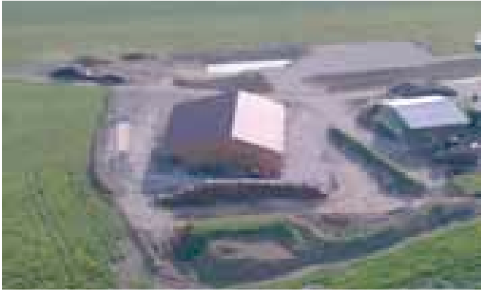
Vue aérienne de la plateforme de Chambœuf (21).
