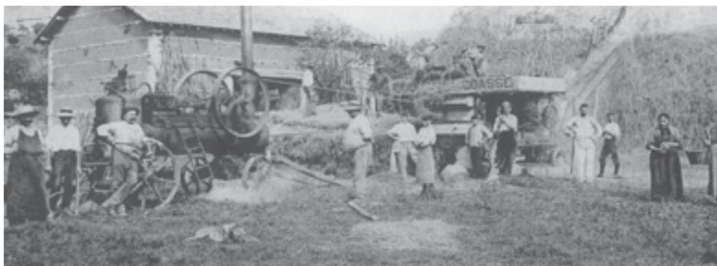
Entreprise de battage J. Dorey, Les-Côtes-d'Arej (38), 1918. La locomobile à vapeur entraîne la batteuse à poste fixe.
