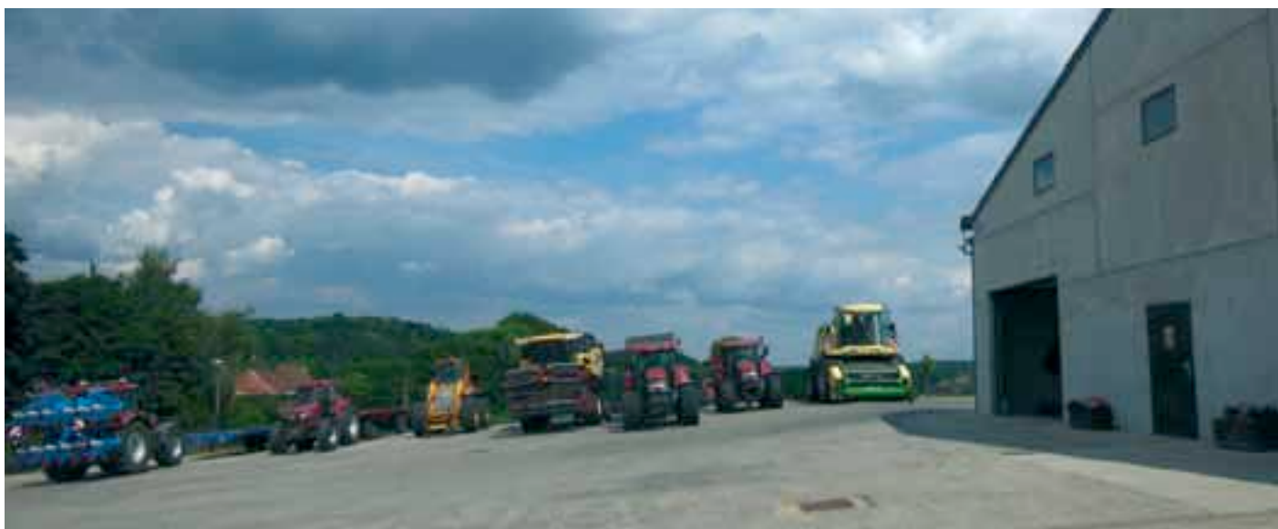
Vue d'ensemble de la cour et d'un des deux hangars.
