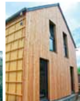
390 000 ha de forêt, soit 14 % de son territoire, ne confèrent pas à la Bretagne un statut de région forestière. Pourtant, il existe une véritable dynamique en transformation, aménagement et construction (ici ossature bois dans les Côtes-d'Armor avec bardage en douglas local).
