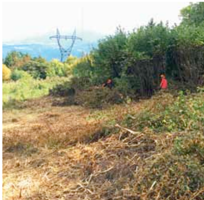
Tranchée forestière sous une ligne RTE sur la commune de Prunières près de La Mure (Isère). Quatre salariés vont y travailler pendant environ deux mois. Les produits d'élagage restent sur place, ou sont broyés par une déchiqueteuse si le chantier traverse une propriété privée ou une commune.
