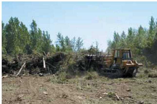
Actuellement, ce sont les chantiers de nettoyage d'après tempête qui sont prioritaires.
