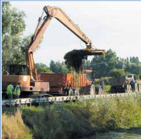
Une des principales activités est l'entretien de canaux et fossés dans la région des Watriunges. Ici, (à gauche) un chantier de faucardage (fauche et enlèvement de la végétation dans les fossés) à la pelle. Ces travaux d'assainissement vont jusqu'au désenvasement des ports comme ci-dessus à Gravelines.
