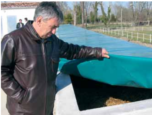
Alain Martineaud présente le biobed étanche de 24 m 3 conçu en fonction de la longueur des rampes de pulvérisation. Ces rampes peuvent être placées juste au-dessus du bac afin de déverser les résidus de produits contenus dans la machine de traitement. Pour accélérer la décomposition des molécules des produits, le bac est rempli de fumier de ses chevaux.
