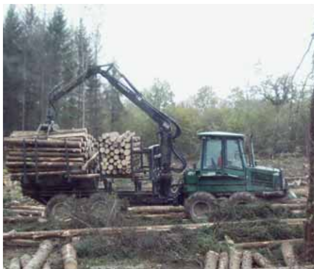
Les machines sont renouvelées régulièrement à la fois pour avoir du matériel « à la pointe » et surtout fiable pour éviter les arrêts de chantier.
