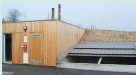
Silo enterré recueillant du bois énergie.
