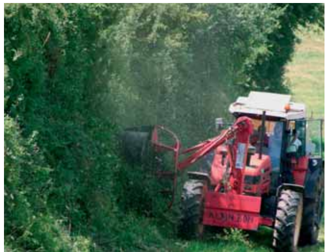
Le premier succès reconnu est cet équipement d'élagage-broyage qui améliore considérablement le rendement du chantier, notamment en supprimant le ramassage des branches.
