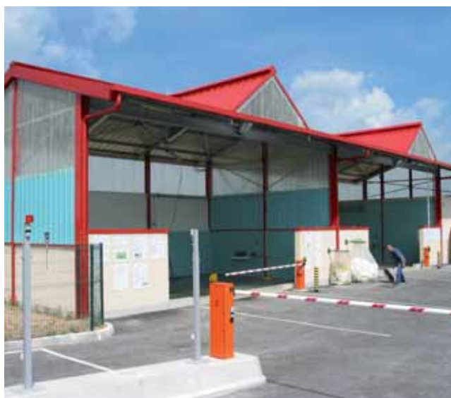
La station d'Avize comporte deux postes de nettoyage et de remplissage.
