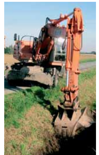
Le curage de fossés à la pelle utilise un système breveté qui améliore le rendement du chantier. Cette activité totalise 1000 Km par an.
