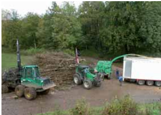
Un chantier demande une logistique appropriée avec les engins adaptés.
