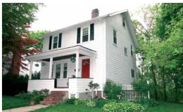
L'année 2008 des mises en chantier aux États-Unis est pleine de désespérance. Après une année 2007 catastrophique, les acteurs du marché espèrent une reprise au cours de l'année. Les constructions américaines sont principalement en bois, on comprend donc facilement que toutes les tensions enregistrées Outre Atlantique ont de graves répercussions sur la filière bois dans son ensemble.
