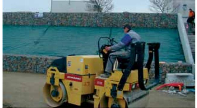
Un lot de voirie, réseau et distribution (VRD) réalisé par l'entreprise à Lorient. Il comprend notamment la réalisation de gabions et un sol formé par du béton désactivé.
