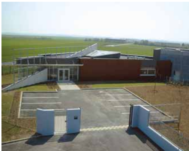
En Picardie, la collectivité de Montdidier a fait le choix des énergies renouvelables. Un réseau de chaleur avec une chaufferie bois de 1 500 kW dessert le lycée, le collège, l'école maternelle, le gymnase et l'hôpital de la ville.
