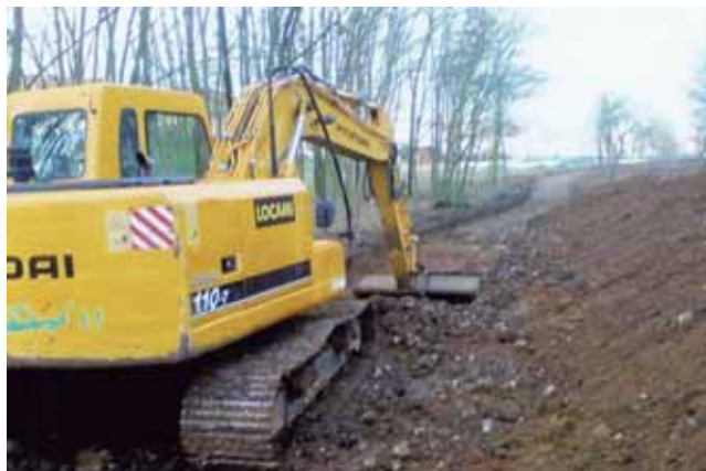
Sur ce chantier situé dans la vallée de Crapaud à Poitiers, l'entreprise a engazonné 5,5 ha. Un chemin terre-pierre a été réalisé.
