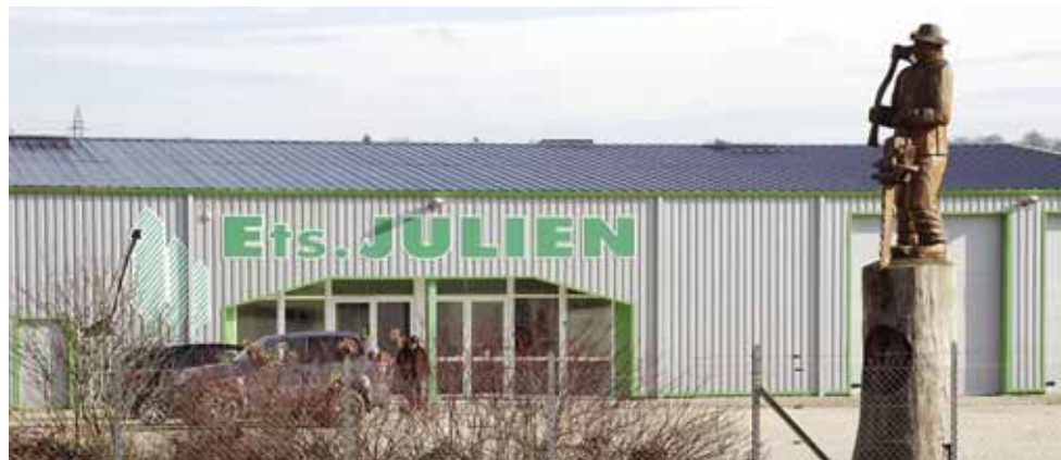
Le siège de la SARL Julien est situé à La Ferrière-aux-Étangs dans l'Orne. Un totem en cèdre finement réalisé à la tronçonneuse symbolise sa spécialité.
