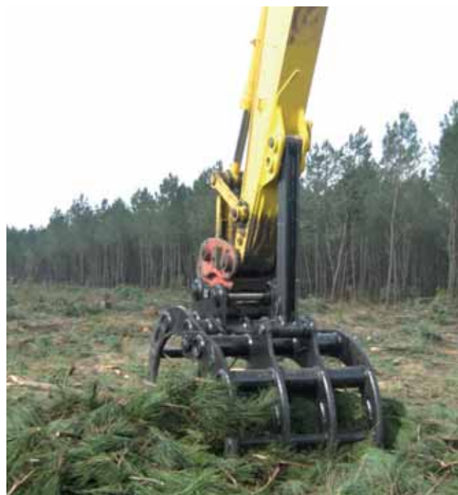
Les entreprises ont développé des moyens mécanisés importants.
