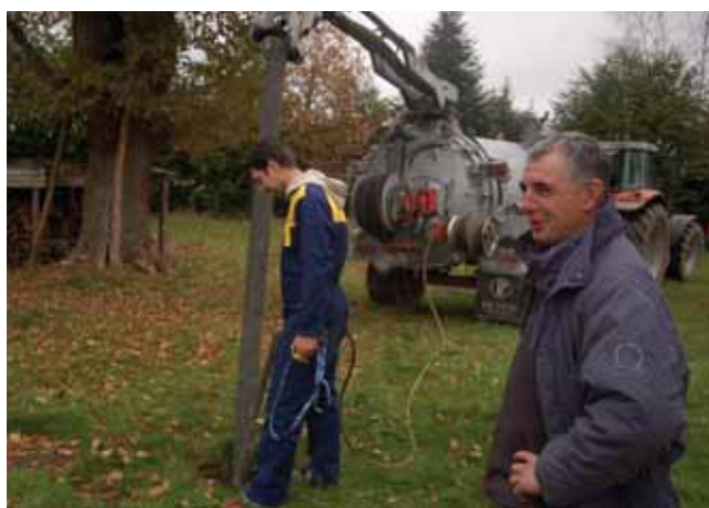
Pour Patrick Magrex, l'hydrocurage est une activité qui lui permet de conserver ses salariés. Cette prestation occupe l'équivalent d'un poste à mi-temps.
