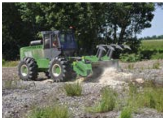
Ce porte-outil Variotrac est le dernier gros investissement de l'entreprise.
