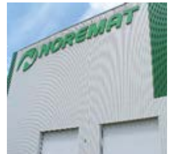
L'extension de 2000 m 2 des ateliers a été juste terminée pour les trente ans de Noremat.
