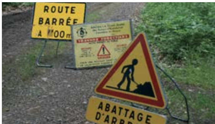
Le signalement et la sécurité du chantier sont une priorité. Les numéros d'appel d'urgence figurent sur les panneaux.
