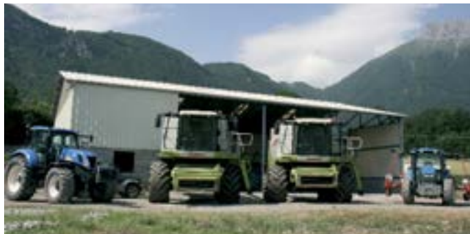
Le hangar, construit en 2010, se situe à 500 mètres de l'habitation. Il sert actuellement d'atelier. Il va être complété cet hiver par un hangar de stockage de 500 m 2 . Jusqu'ici, le matériel est stocké au siège de l'exploitation de Jean-Michel, située à 1 km.
